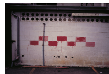
7 ブロック塀にペイント 1991 ソウル
