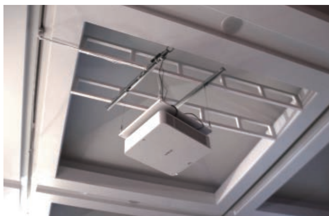
挿図13 改修前の折上格天井内プロジェクター設置例
