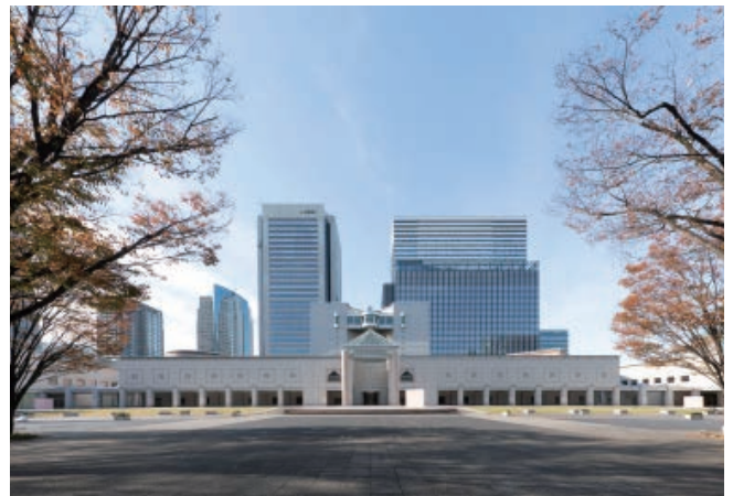
挿図1 横浜美術館外観（撮影：（株）エスエス）、2023年 構造：鉄骨鉄筋コンクリート造、一部、鉄筋コンクリート造、 鉄骨造8階建（一部3階建）、敷地面積：19,803㎡、建築面積： 9,621㎡、延床面積：27,014㎡、設計：丹下健三・都市・建築 設計研究所、監理：横浜市建築局、丹下健三・都市・建築設 計研究所、改修工事設計監理：株式会社丹下都市建築設計
